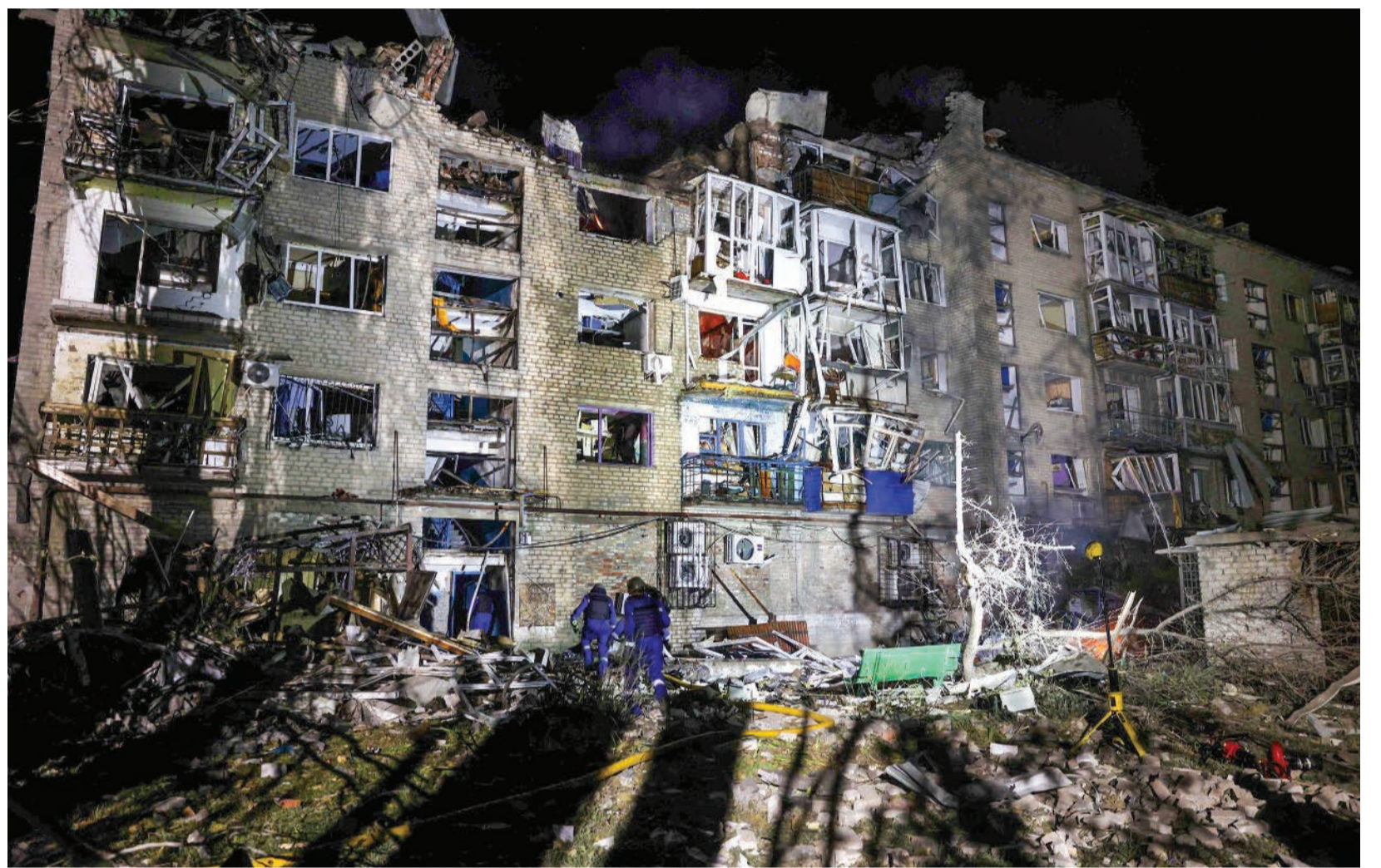
Un bâtiment résidentiel endommagé suite à des frappes de missiles russes à Pokrovsk, dans la région de Donetsk, en Ukraine. Anatolii Stepanov/AFP
