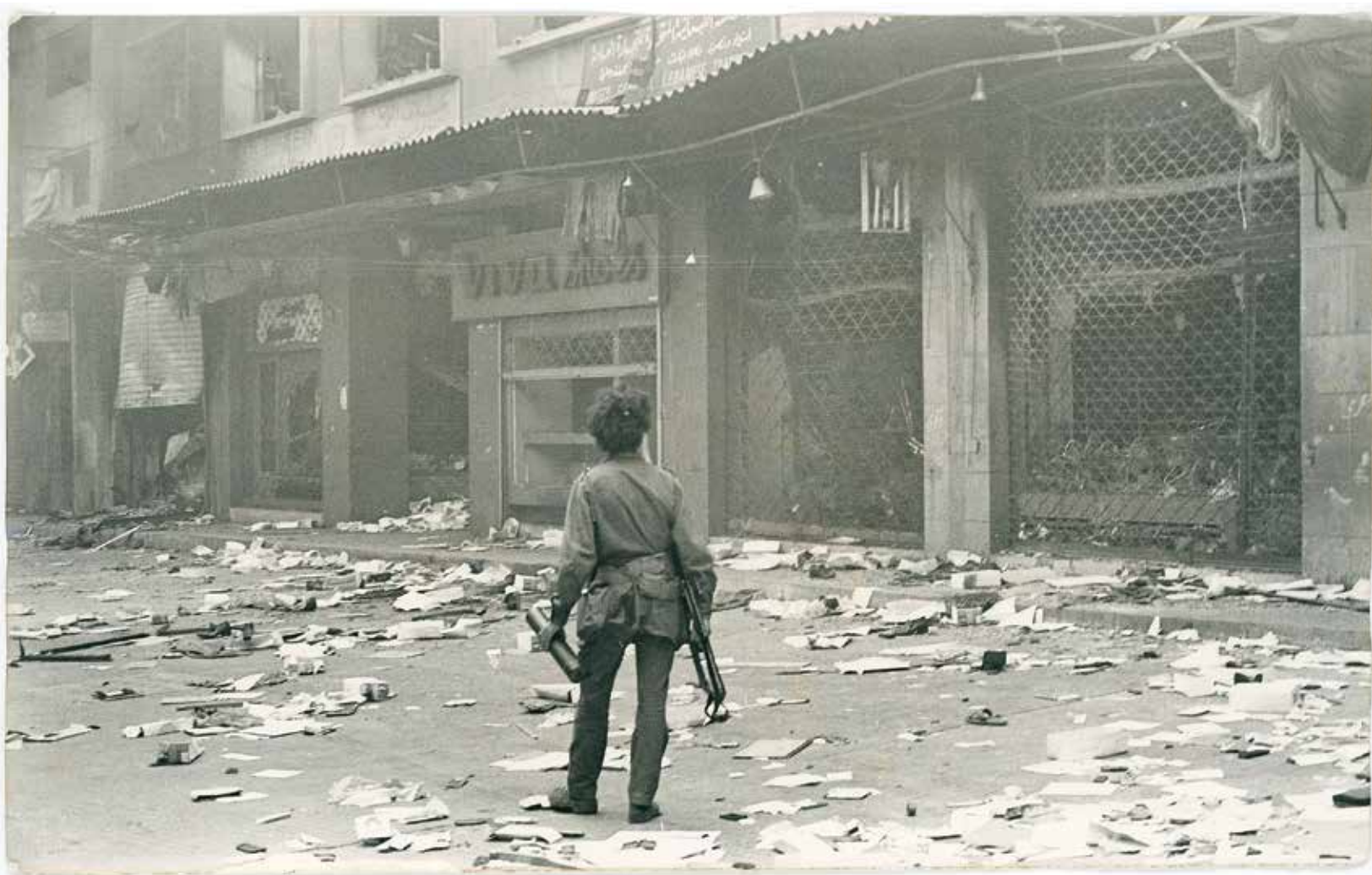
Septembre 1975. Un milicien se tient au milieu des ruines du centre Azariyé, à Beyrouth. Collection Georges Boustany
