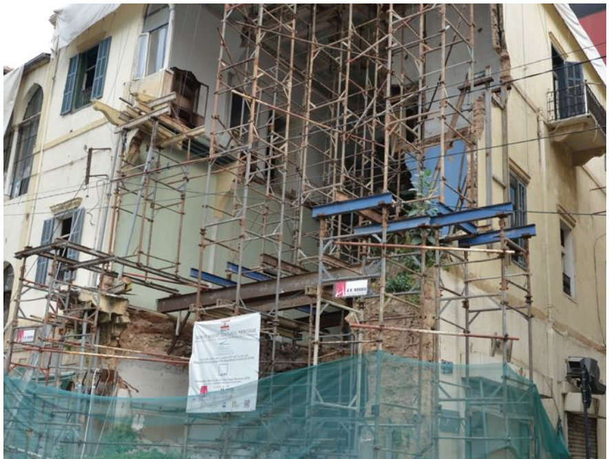
Des travaux de reconstruction de façades de bâtiments historiques, dans le centre de Beyrouth, suite aux dégâts provoqués par l'explosion dévastatrice du 4 août 2020.
